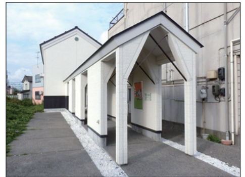
APM・蔵 外観
